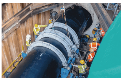
▲ 水務署進行水管改善工程。
